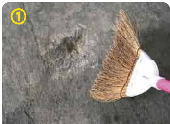
① ゴミを取り除く (油分は洗浄する)
